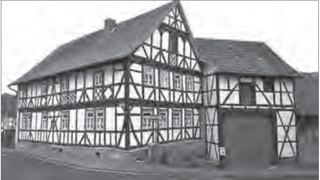
Abb. 1: Haus Rodegasse 6, Zustand 2018. Foto: B. Lange.
